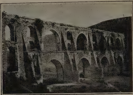
Fig. 80. — Aqueduc dit de Justinien, près de Constantinople (d'après Strzygowski, Die byzantinischen Wasserbehälter von CP ).
